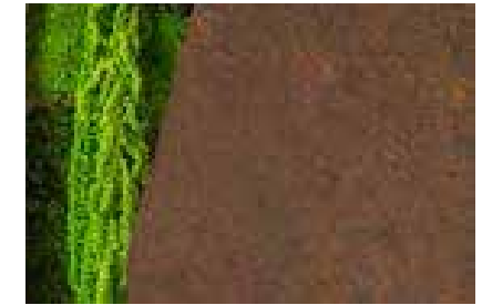
tôle rouillée et végétal stabilisé
